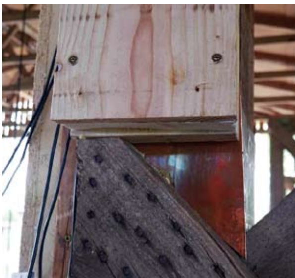
Abb. 2: Detailaufnahme der zu behandelnden Stütze mit angebrachtem Kupferblech
