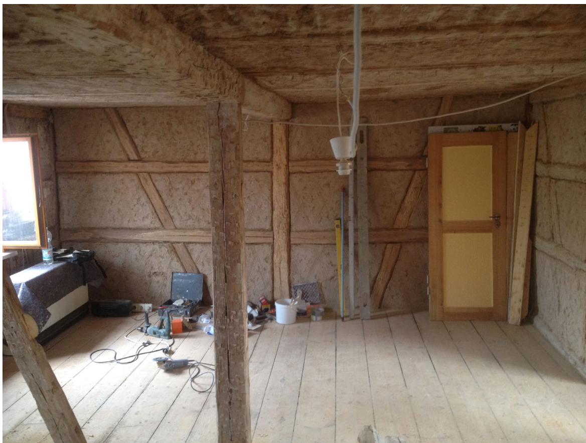
Abb. 4: Renovierung im Altbau mit Lehm (Quelle: M. Blei)
