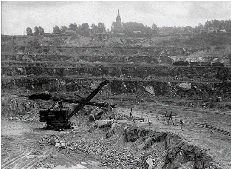
Abb. 8: 1944: Der damals größte Bagger Kanadas belädt einen Erzzug mit Asbest in der Jeffrey Mine. (Quelle: Harry Rowed wikimedia)
