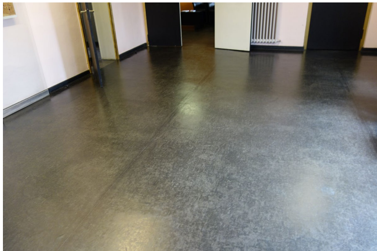
Abb. 3: Der alte Triolinbelag in einem Bauhaus-Meisterhaus in Dessau kann nicht mehr zeitgemäß gesäubert werden
