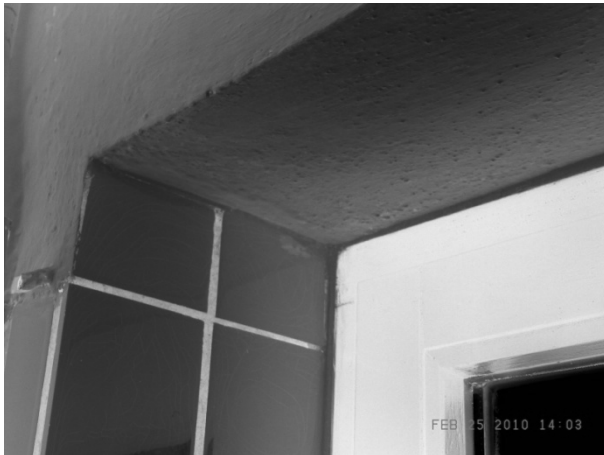
Bild 5.6: Fenstergewände und Raumdecke nach Sanierung
