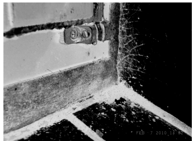
Bild 5.2: Schimmelbildung und Betauung am Fenster
