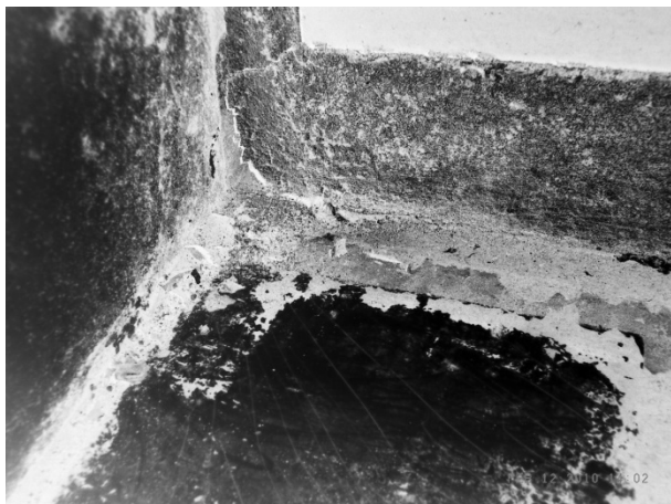
Bild 5.4: Vertrockneter sich ablösender Schimmel
