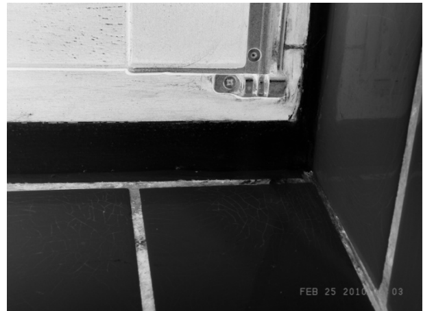
Bild 5.7: Fenstergewände und Fensterbank nach Sanierung
